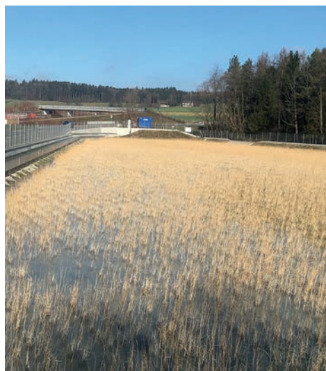
Abbildung 36 Strassenabwasser-Behandlungsanlage (SABA) in Zürich-Affoltern.
