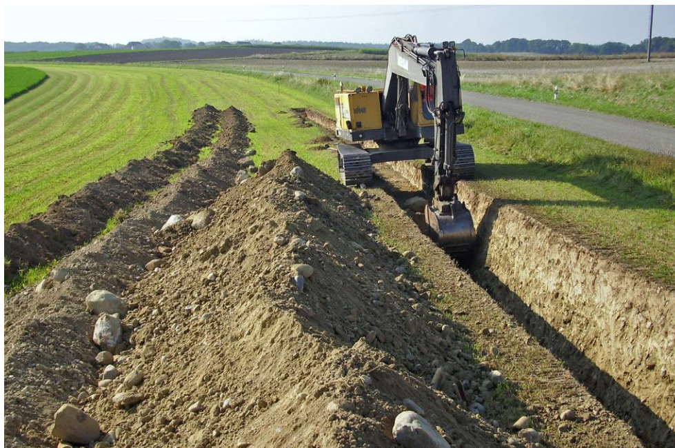
Abb. 28 > Linearer Aushub mit Raupenbagger auf gewachsenem begrüntem Boden
