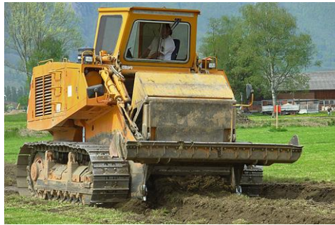
Abb. 30 > Bodenwiederherstellung mit Planierfraupe unter feuchten Bedingungen
